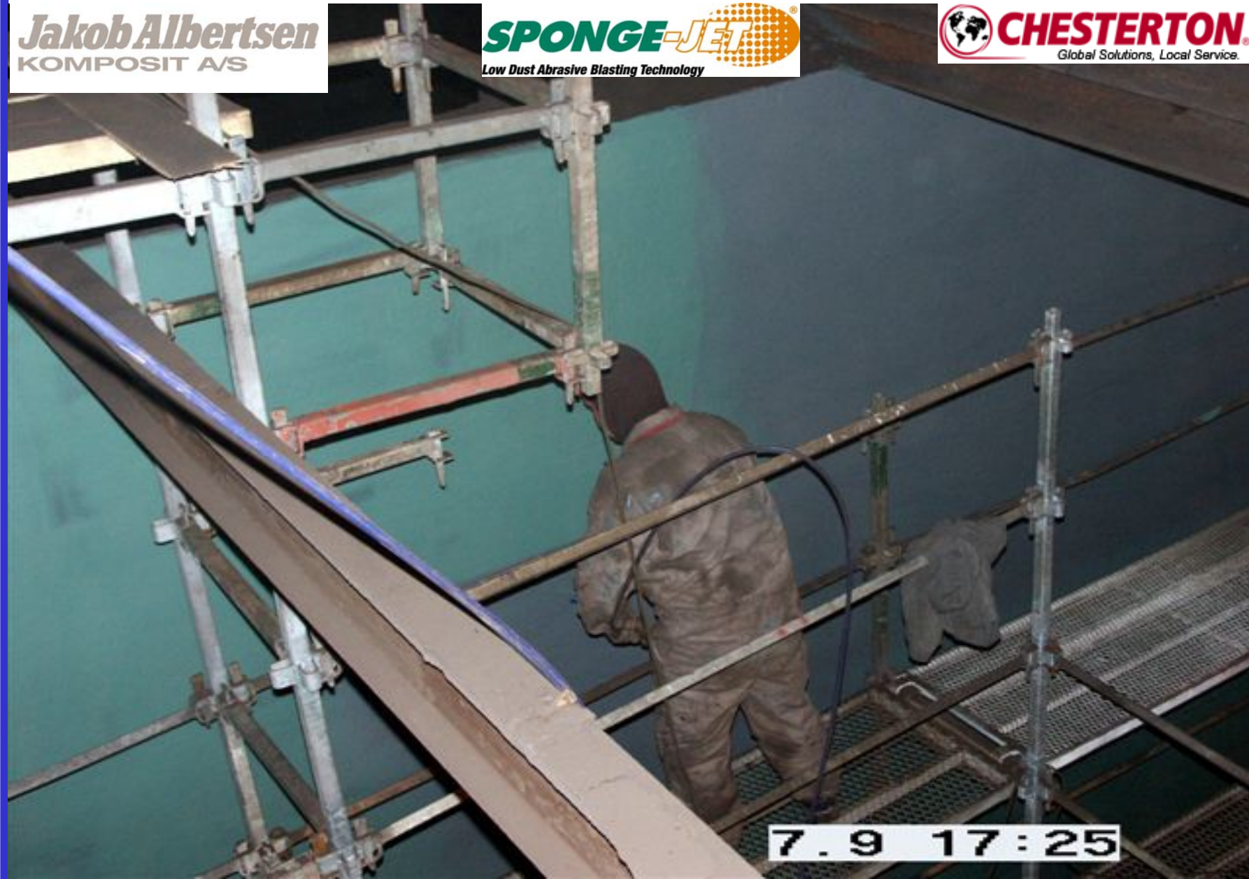
ARC coating af kulsilo fra Finland ARC S 2.
